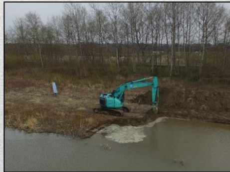
1 重機を使った掘削
