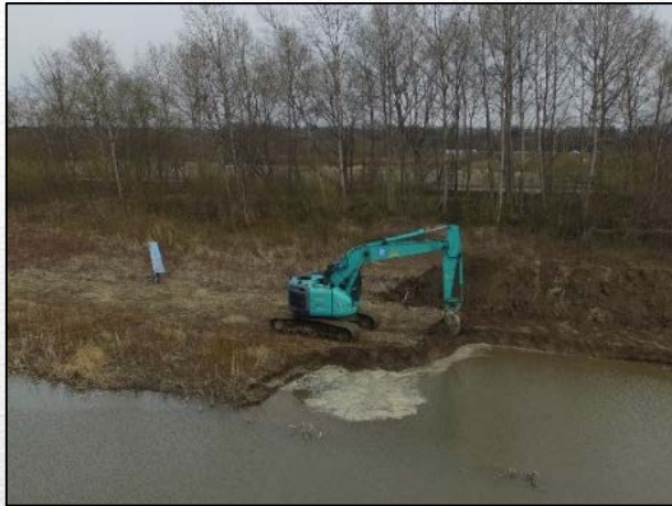
掘削状況(ドローン撮影:4月22日)
