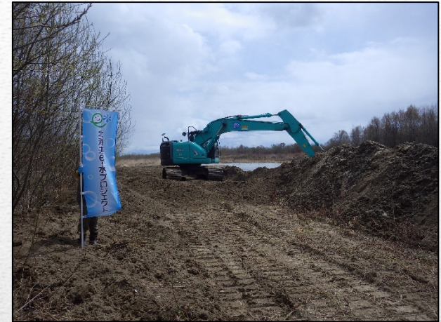
掘削状況(4月23日)
