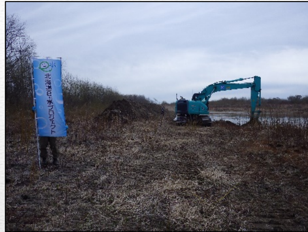
掘削状況(4月22日)
