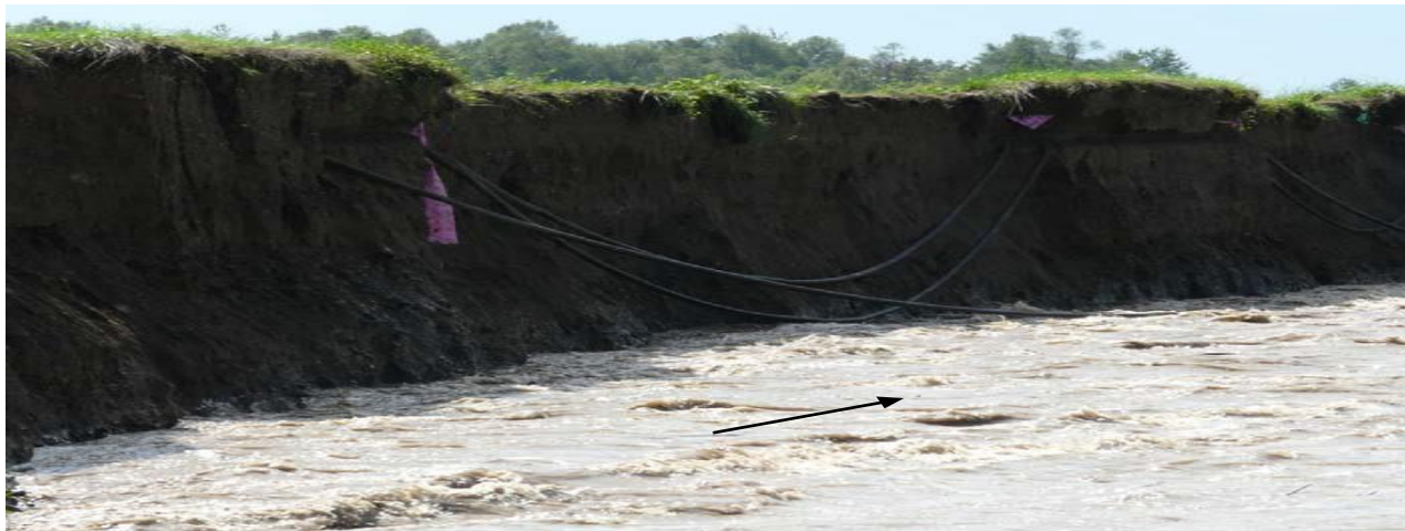
写真3-3 流出部の侵食面（上流側から撮影。H23.9.7 AM10:14撮影）
