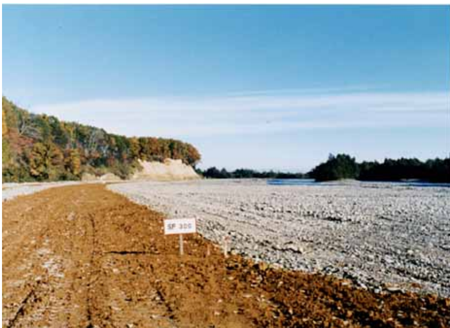
工事完了時（平成9年）
