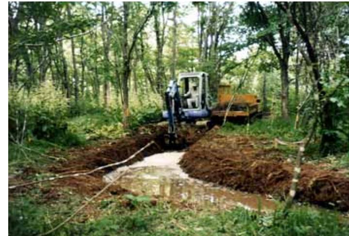
掘削ライン上を通過して 土を搬出する
