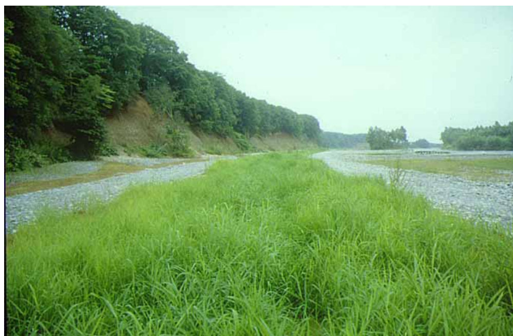
工事1年後（平成10年）
