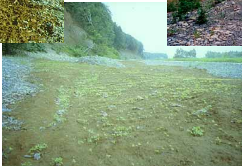
工事1年後(平成10年)
