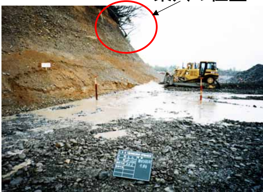
影響があると考えられた押し土の作業
